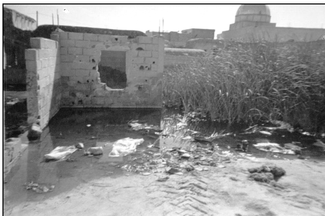
Photographie 2 : Détérioration et effondrement des habitations (Remini, 2004)
