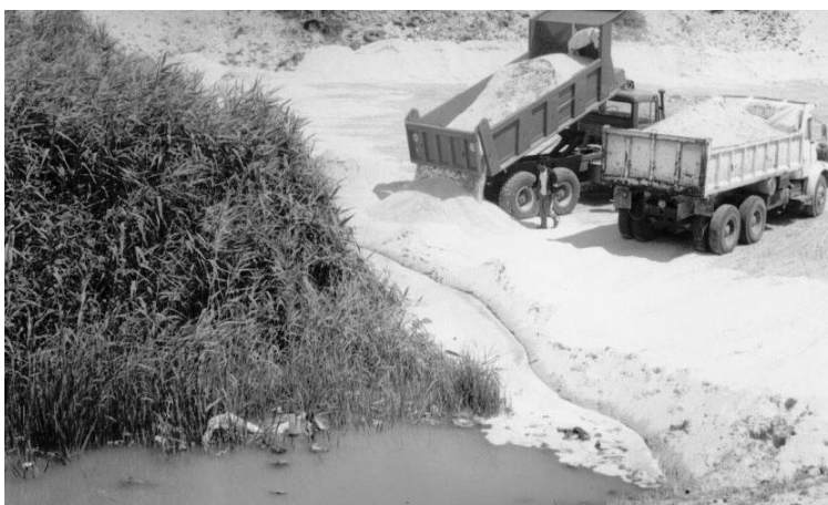
Photographie 3 : Opération de remblaiement des Ghouts (Remini, 2002)
