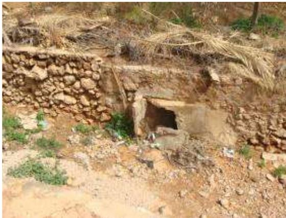
**Figure 42 : Koua dégradée, mur en terre inexistant depuis la crue de 2008 (Photo. Remini, 2013)**
