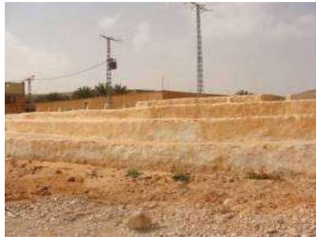
**Figure 11 : Grand évacuateur de crues du barrage de régulation de Touzouz (partie aval) (Photo. Remini, 2006)**
