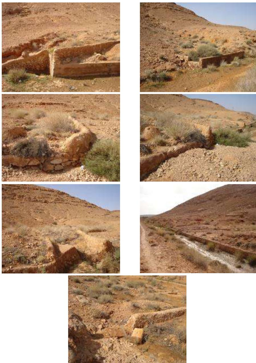
**Figure 26 : Quelques types d'ouvrages hydrauliques réalisés pour la collecte des eaux pluviales dans le cadre de l'aménagement IRS de Touzouz (Photo, Remini, 2014)**
