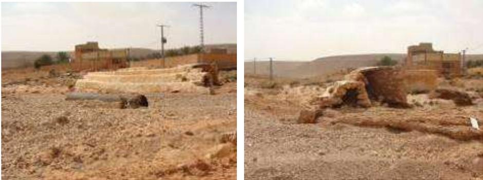
**Figure 40 : Digue du grand barrage complètement emportée par la crue (Photo. Remini, 2009)**
