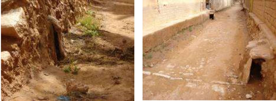
**Figure 33 : La Koua ; Chaque jardin est muni d'une ouverture rectangulaire aménagée en bas du mur pour permettre à l'eau de crue de s'écouler dans les jardins (Photo. Remini, 2011)**
