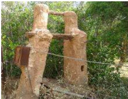
**Figure 36 : Khotta de la vallée de M'zab : Un puits à traction animale (Photo. Remini, 2012)**
