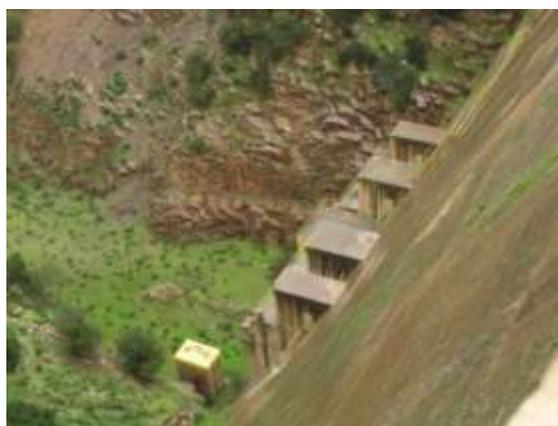
**Figure 46 : Barrage d'Oued Fodda ; Cinq pertuis de vidange pour le soutirage des courants de densité (Photo. Remini, 2008)**
