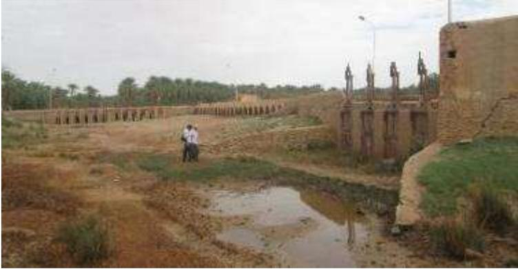
**Figure 20 : Système de partage et d'évacuation des eaux de crues (Remini, 2019)**
