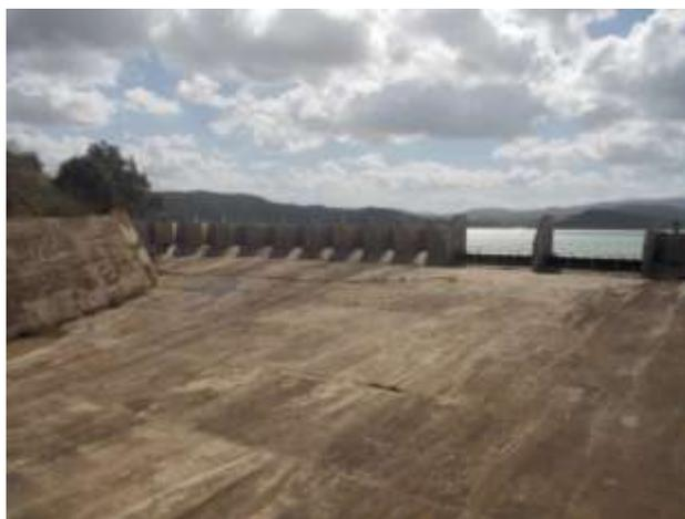
**Figure 39 : Surélévation du déversoir du barrage de Ghrib par les faux fusibles (Remini, 2019)**
