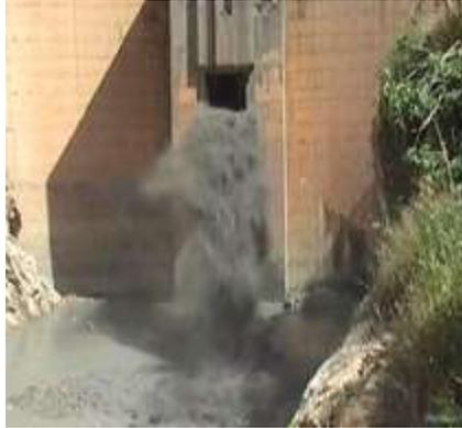
**Figure 47 : Barrage de Foum El Gherza : Evacuation de la vase drainée par la crue (Photo. Remini, 2010)**
