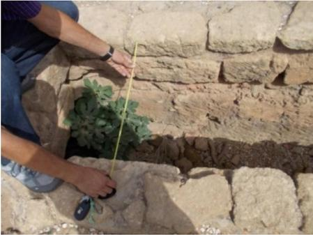
**Figure 22 : Canal d'évacuation des eaux pluviales dans l'ancienne ville Romaine (Tipasa) (Photo. Remini, 2018)**
