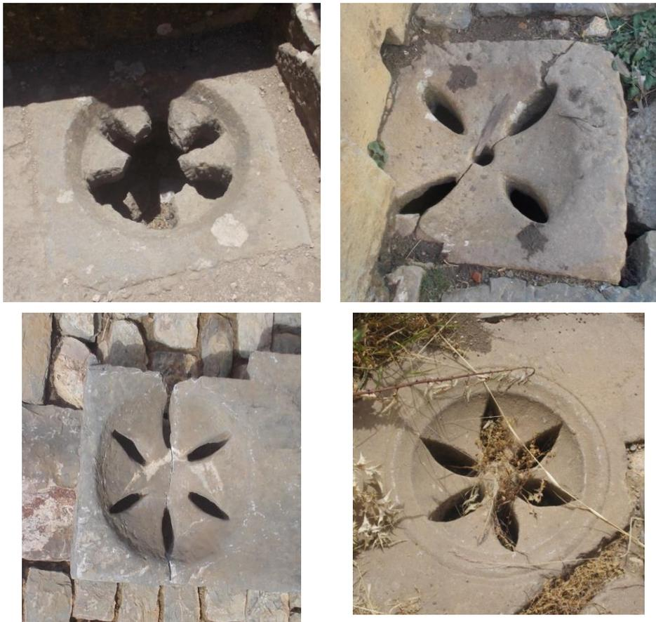
**Figure 25 : Avaloirs avec anti vortex utilisées dans l'ancienne ville de Djemila (Photo. Remini, 2018)**
