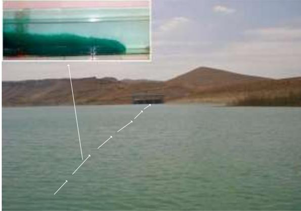
**Figure 12 : Parcours des courants de densité dans la retenue du barrage de SMBA (Photo. Remini, 2013)**
