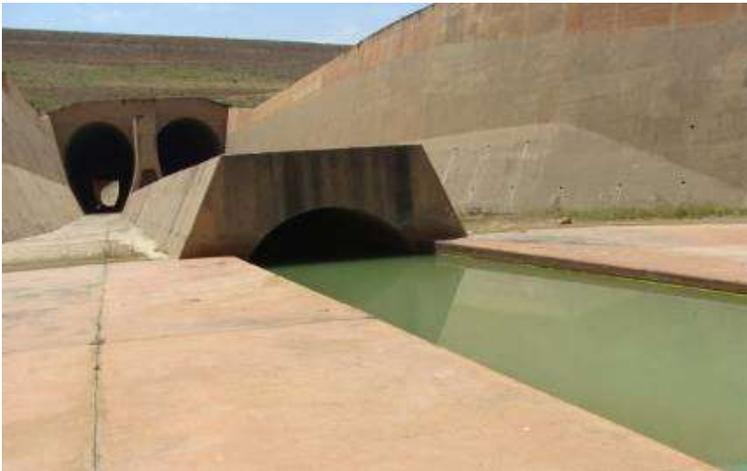
**Figure 24 : Canal de sortie de la vanne de fon gauche (Photo. Remini, 2014)**
