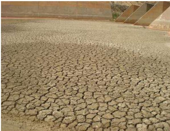
**Figure 28 : Dépôt de vase après une opération de soutirage (Photo. Remini, 2018)**
