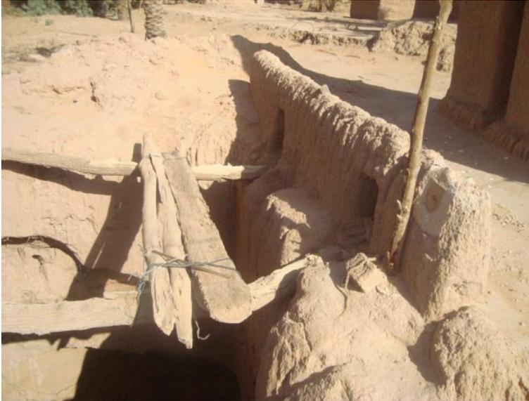
**Figure 17 : Des troncs d'arbres d'Arar et de palmiers placés sur le puits d'une Khottara de Kerzaz (Cliché Remini, 2014)**
