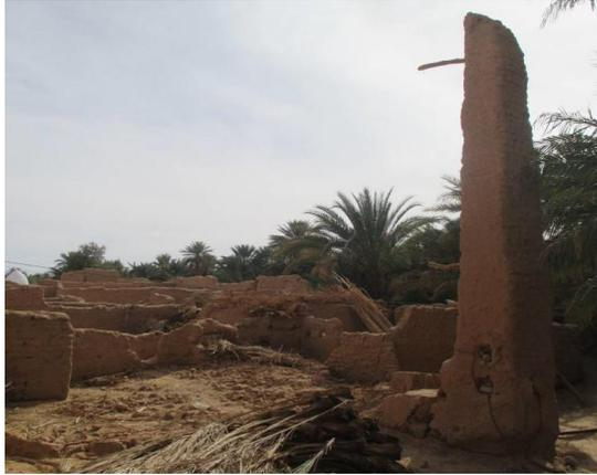
**Figure 23 : Effondrement du montant d'une Khottara de l'oasis de Kerzaz lors de la crue de 2008 (Photo. Remini, 2014)**
