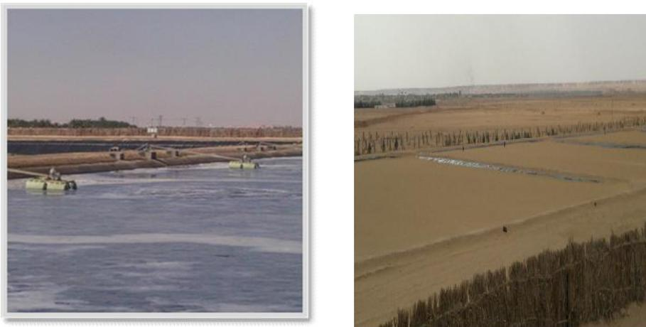
**Figure 3 :** Lagune d'aération et lits de séchage
