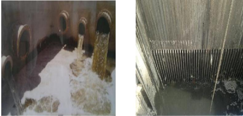
**Figure 1 :** Bassin de dégazage et dégrilleur.
