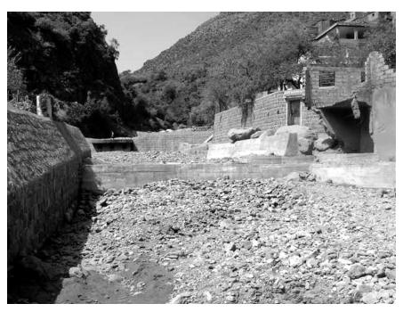
**Figure 11 :** Seuils d'amortissement de l'affluent Tighzirt comblés par les dépôts
